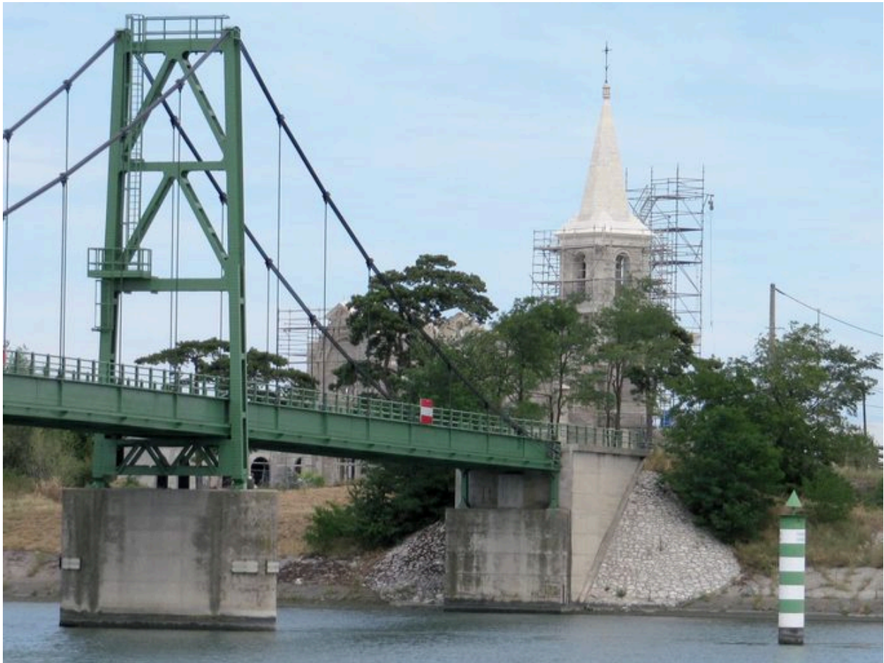
Travée de rive gauche et culée, face aval (depuis la rive droite)
