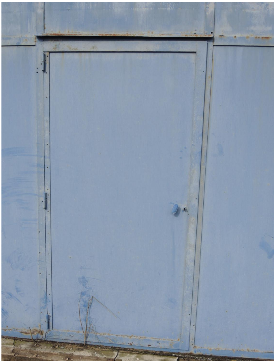
Hangar VI, porte extérieur avec poignée d'origine.
