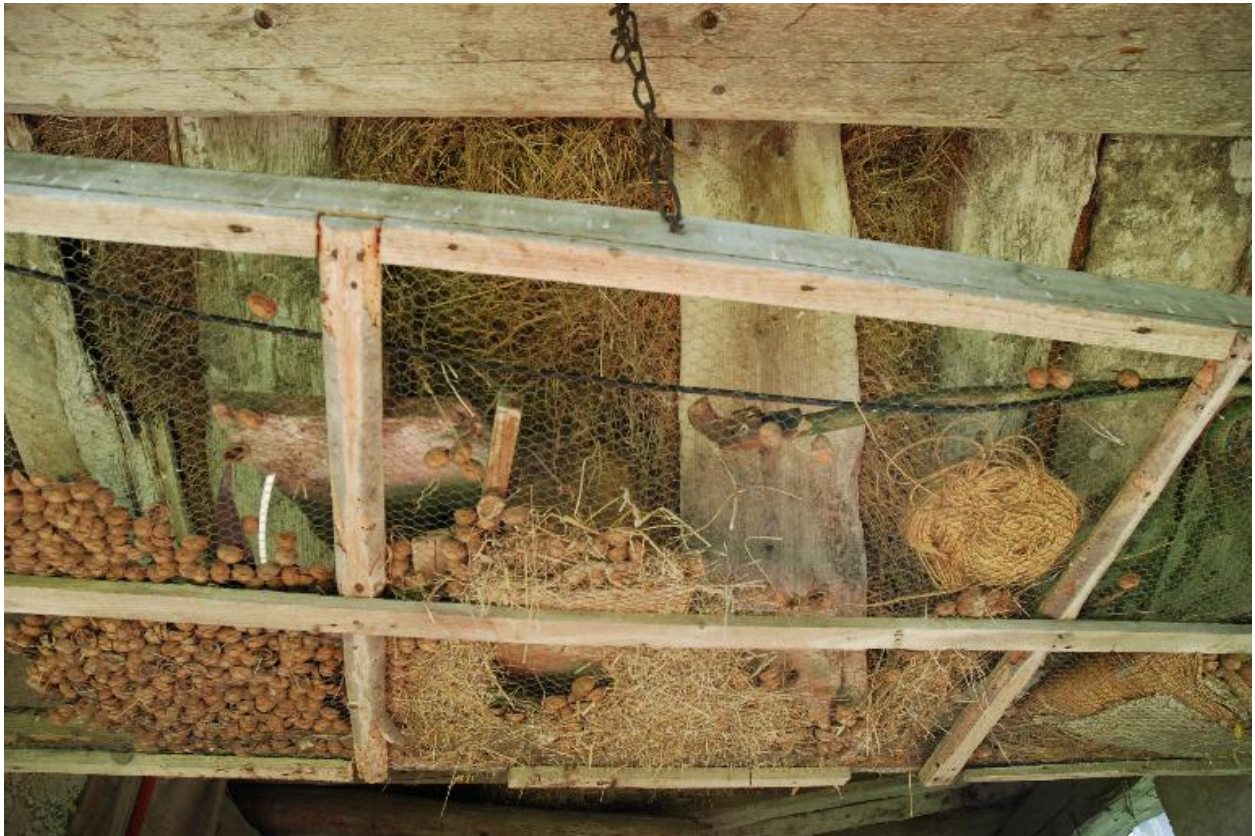
Détail du séchoir à noix protégé par l'avant-toit de la grange-étable.
