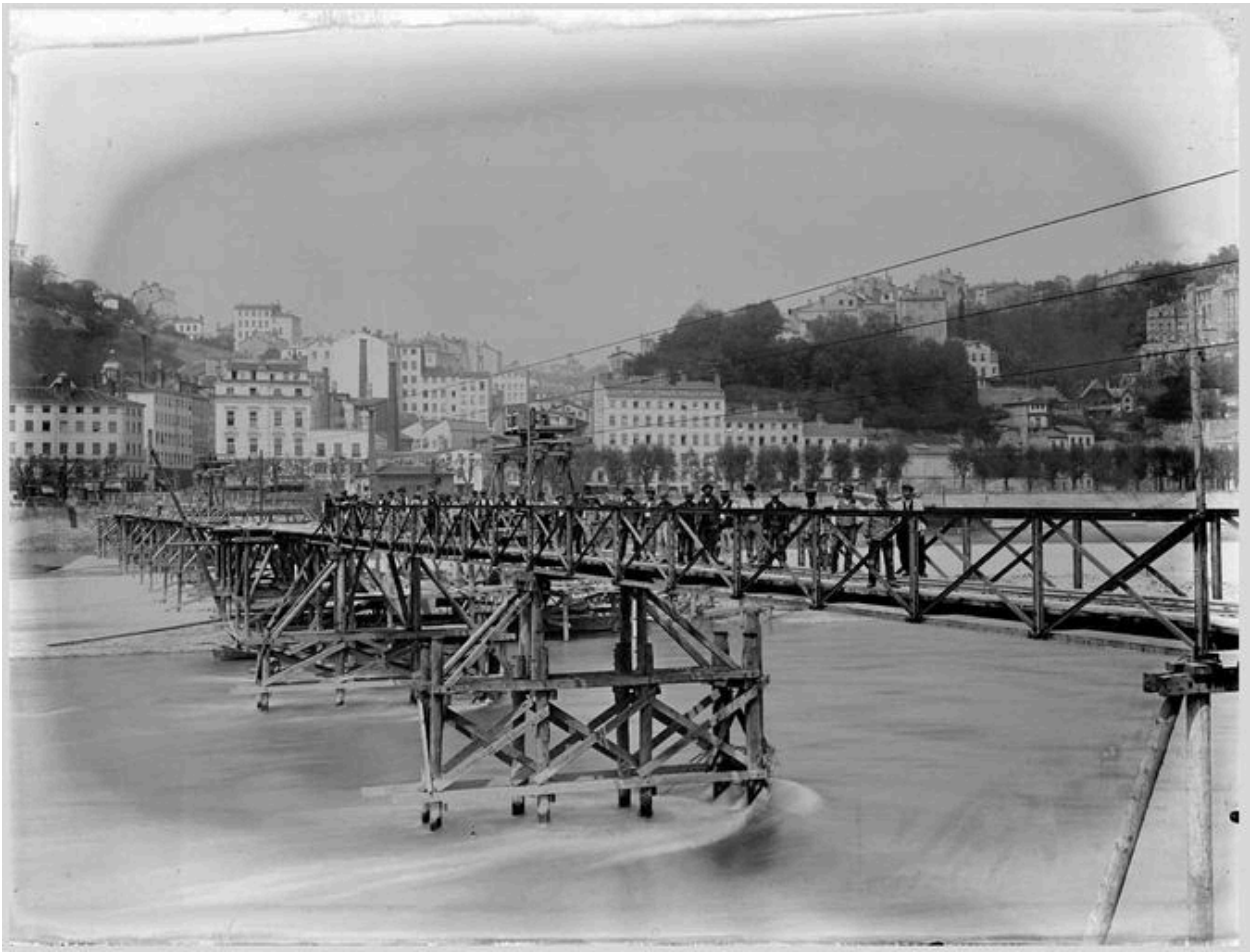
La construction du pont de la Boucle. Charpente de soutien des premiers éléments du tablier. [1902]. 1 fotogr. : n. et b. (AM Lyon. 15 Ph 1795)
