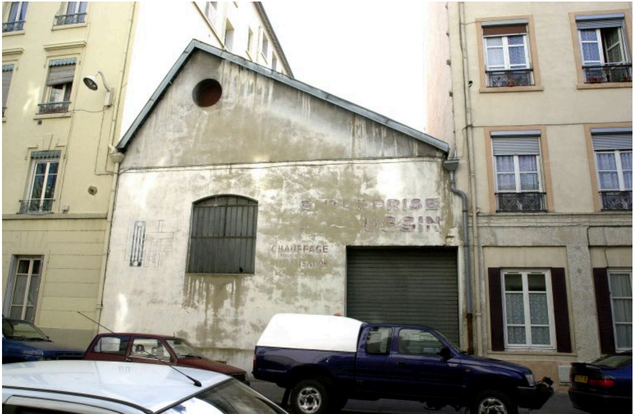
Vue générale ouest de l'entreprise Roussin rue Denuzière
