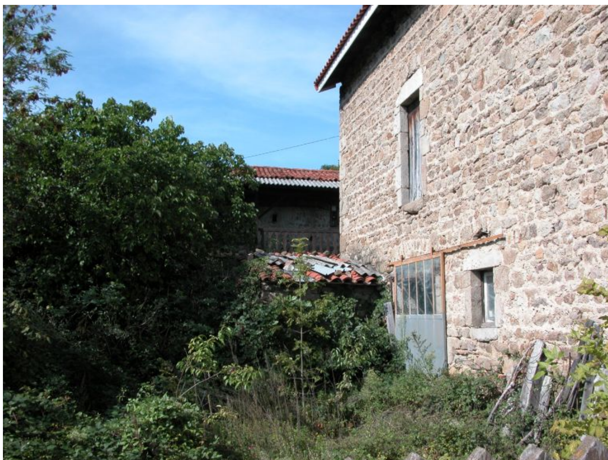
Détail de l'accès à l'étable, façade latérale sud de la grange-étable.
