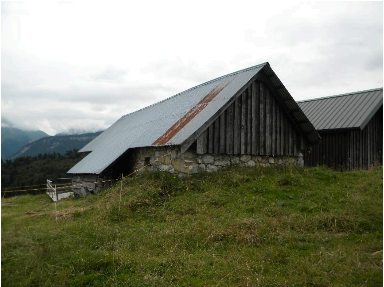
Vue de trois-quarts nord-ouest d'un bâtiment ancien modifié.
