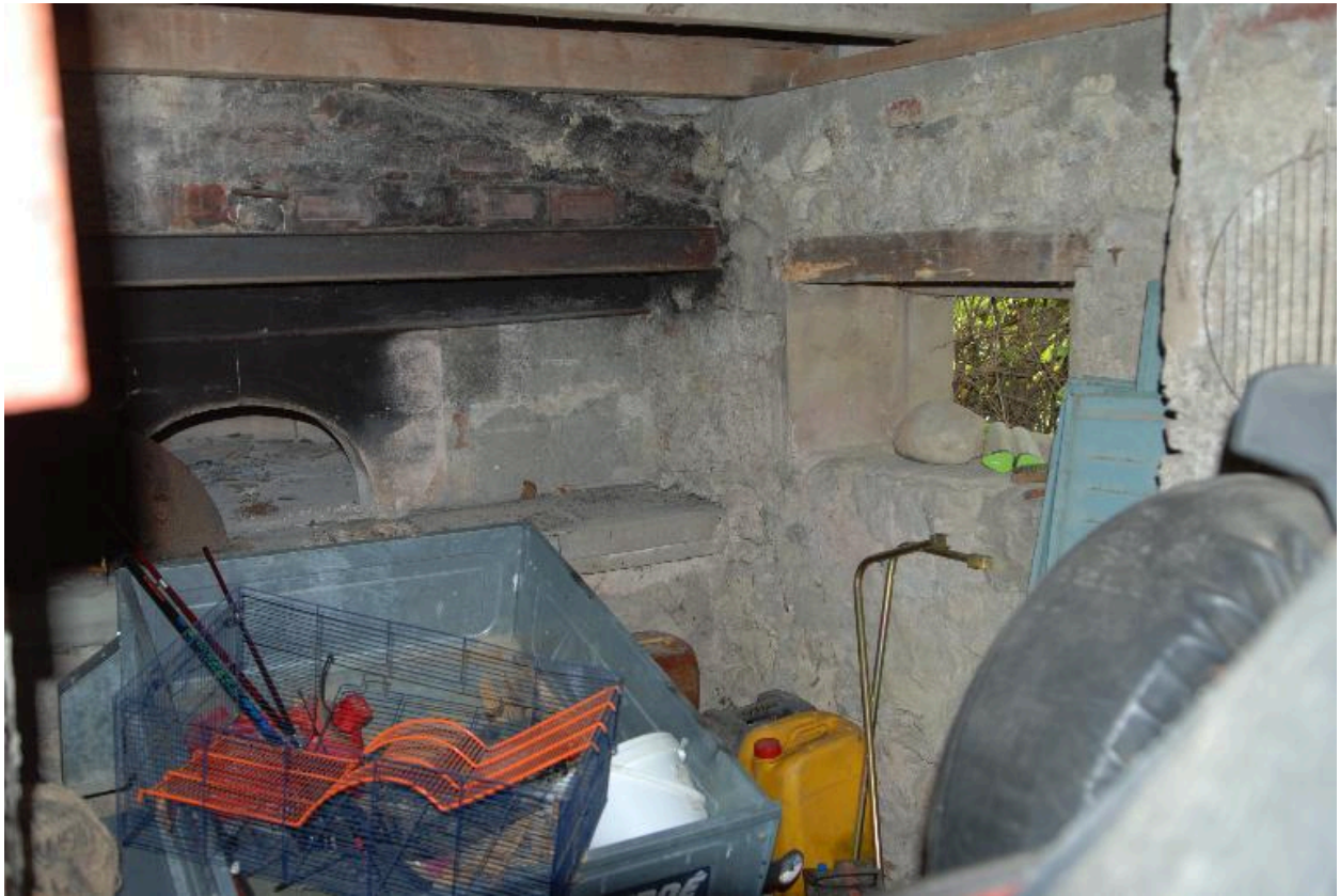
Détail de la petite niche transformée en petite baie.
