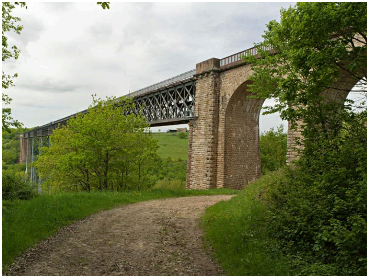
Vue de trois quarts du viaduc depuis le bas.
