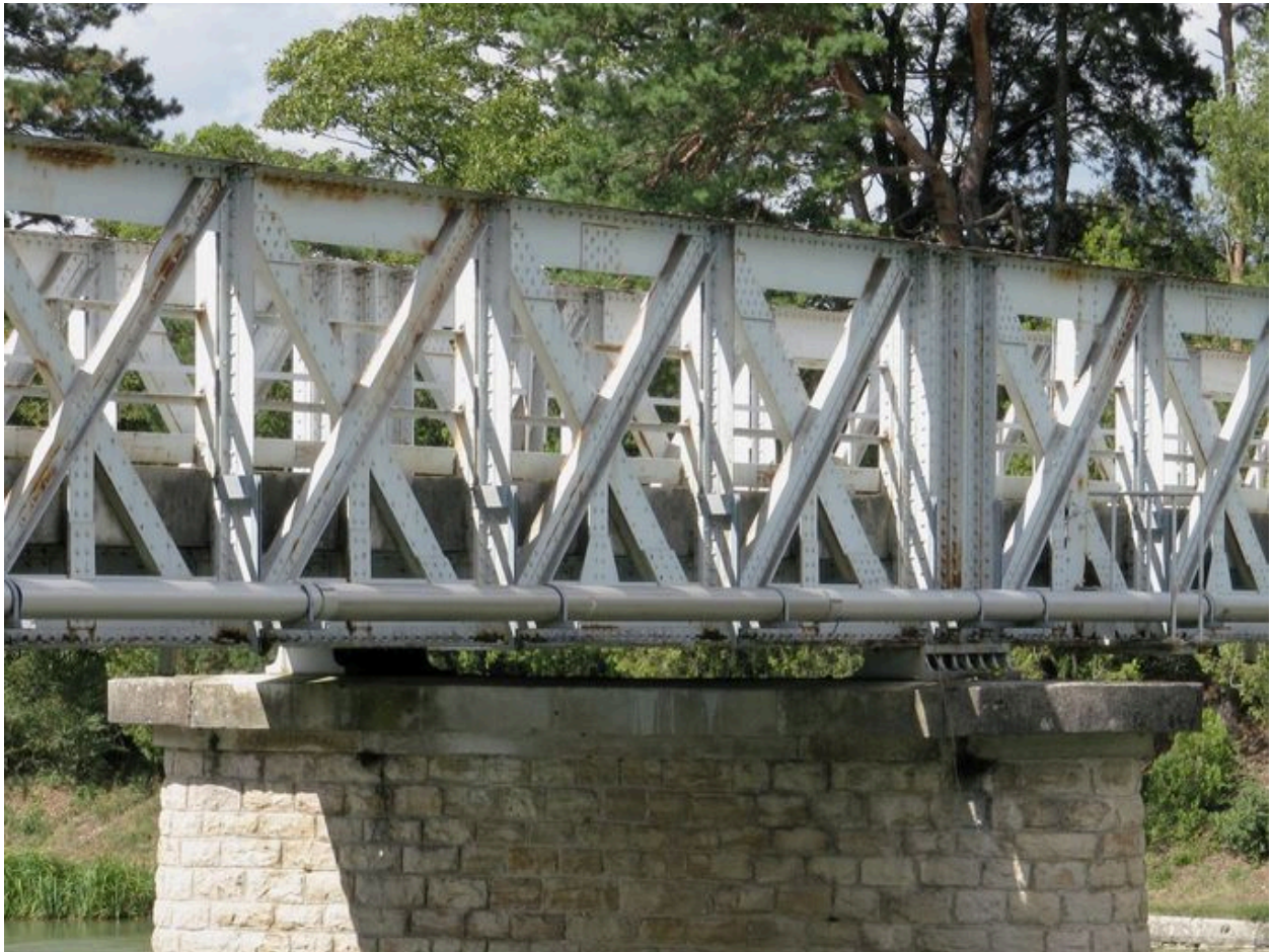
Tablier, face amont, vue partielle : jonction avec la pile (depuis la rive gauche)
