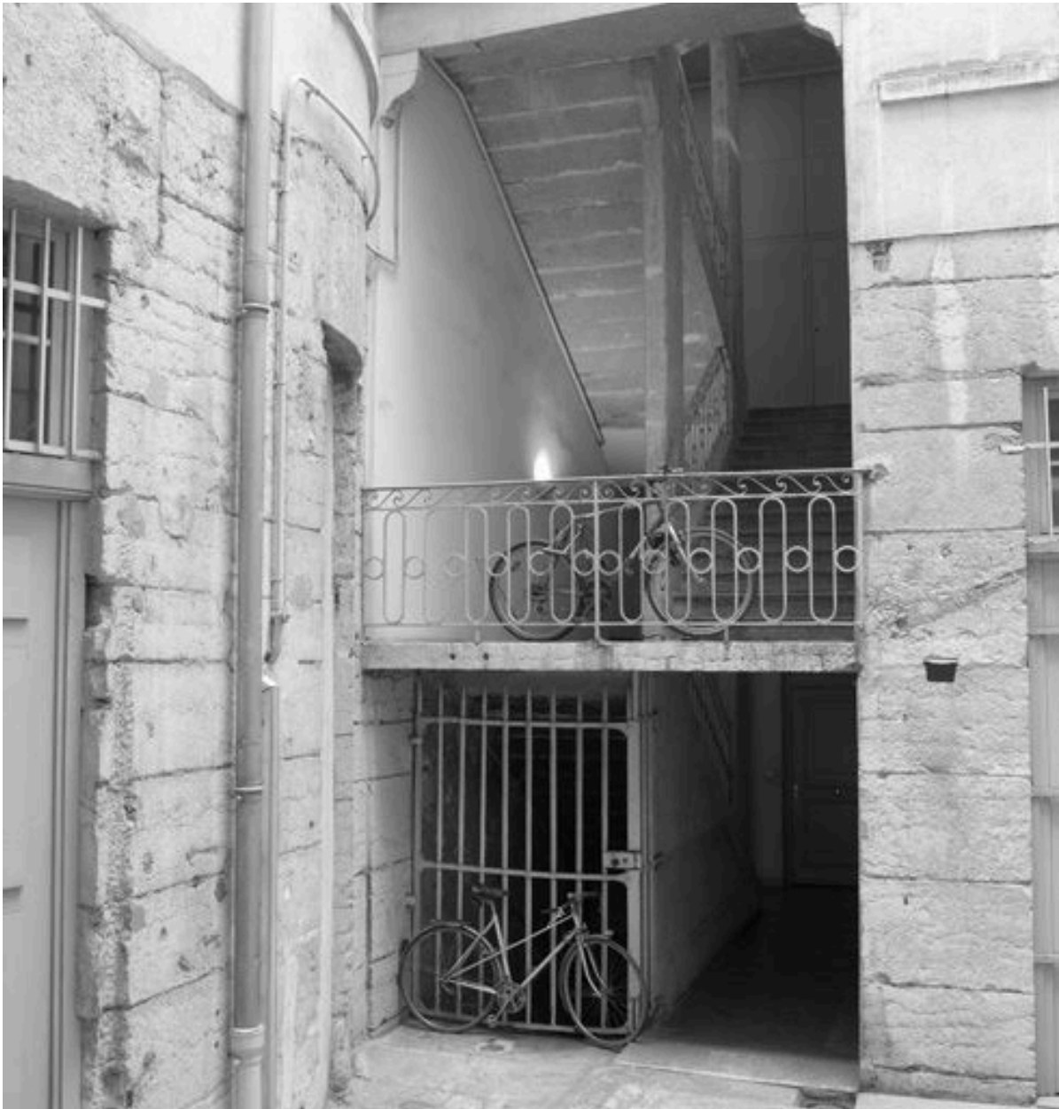
Première cour, partie inférieure de l'escalier du premier corps
