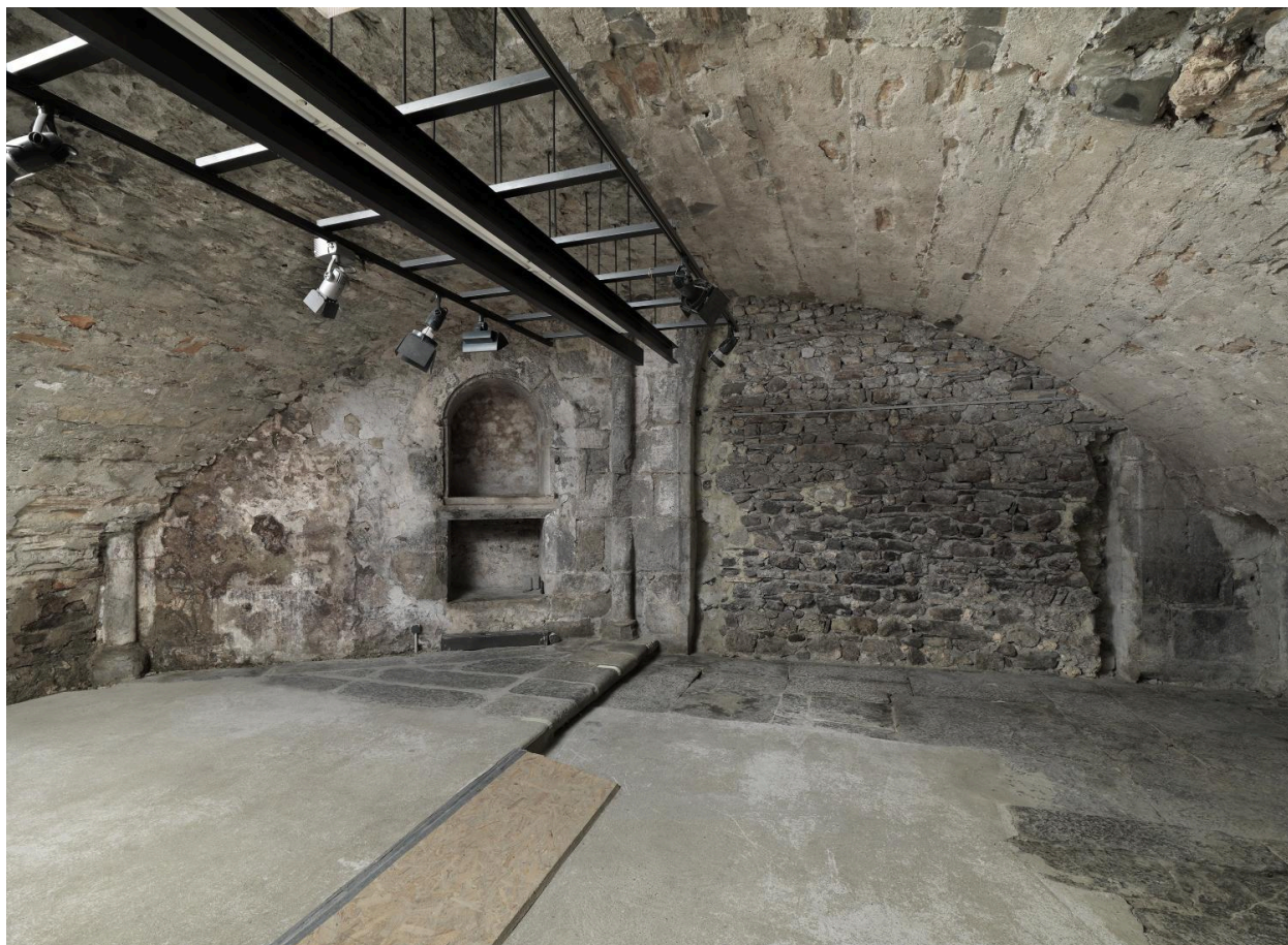
Vue intérieure des vestiges du choeur ("caveau des Augustins"), mur est : lavabo, ouverture (murée) vers l'extrémité du collatéral est.
