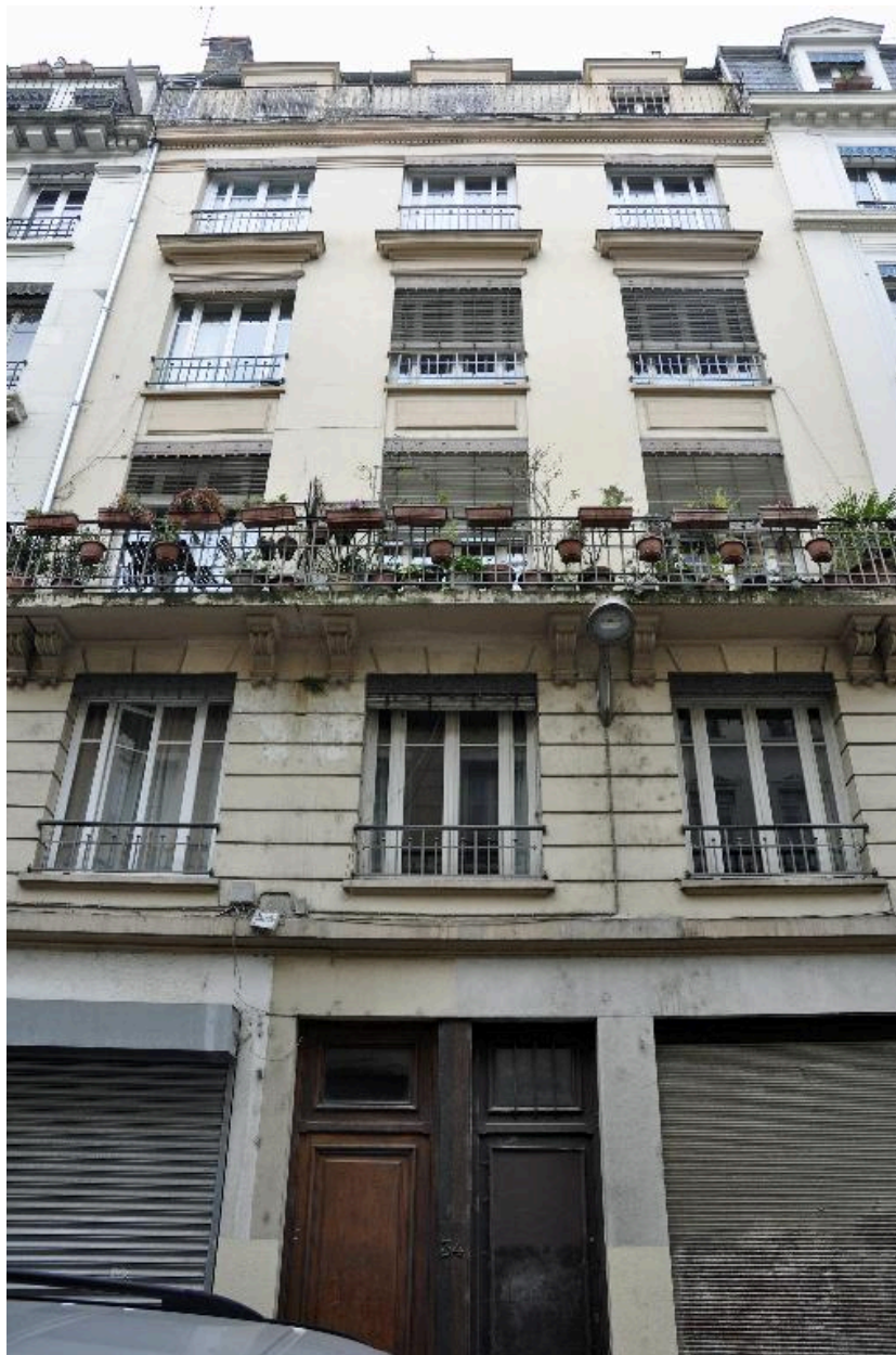
Vue générale de l'élévation sur rue
