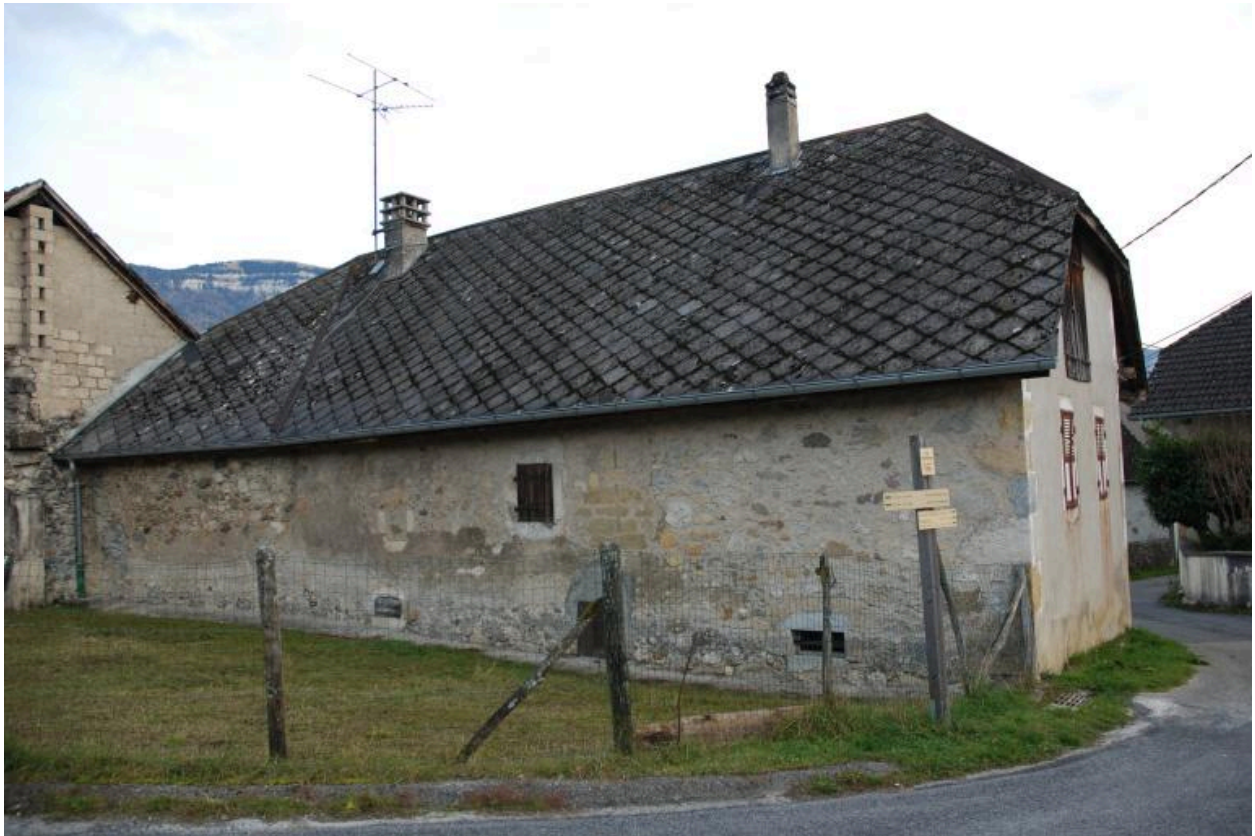
Vue arrière de l'habitation ouest.
