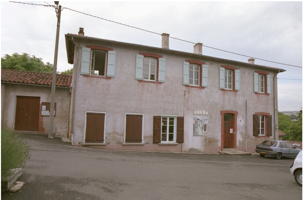
Vue d'ensemble de l'actuelle école communale, élévation antérieure (1987 A1 370).
