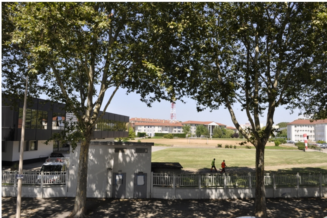
Vue du QGF : terrain de sport, réfectoire et bâtiment construit dans les années 80. Vue prise depuis la rue des Girondins, dans un bâtiment au second étage.
