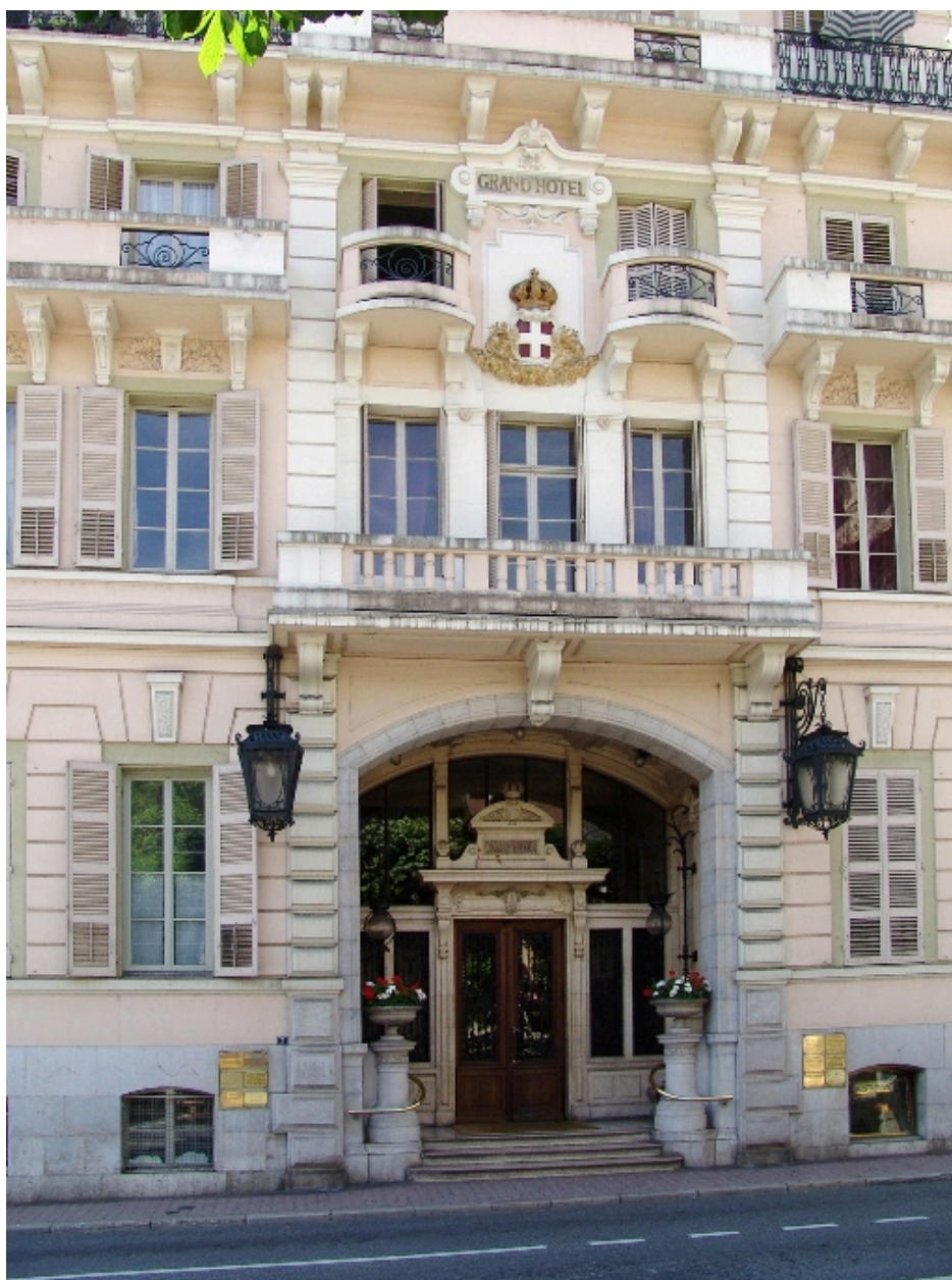
Travée centrale de la façade
