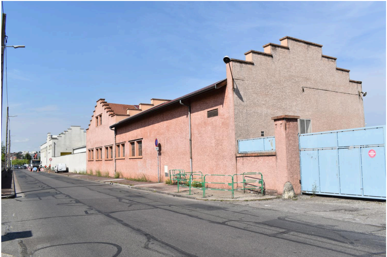
Véninov - vue sur l'usine depuis la rue Eugène Maréchal
