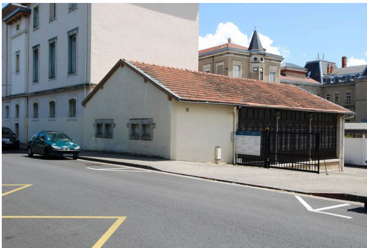
Vue générale d'un bâtiment annexe.
