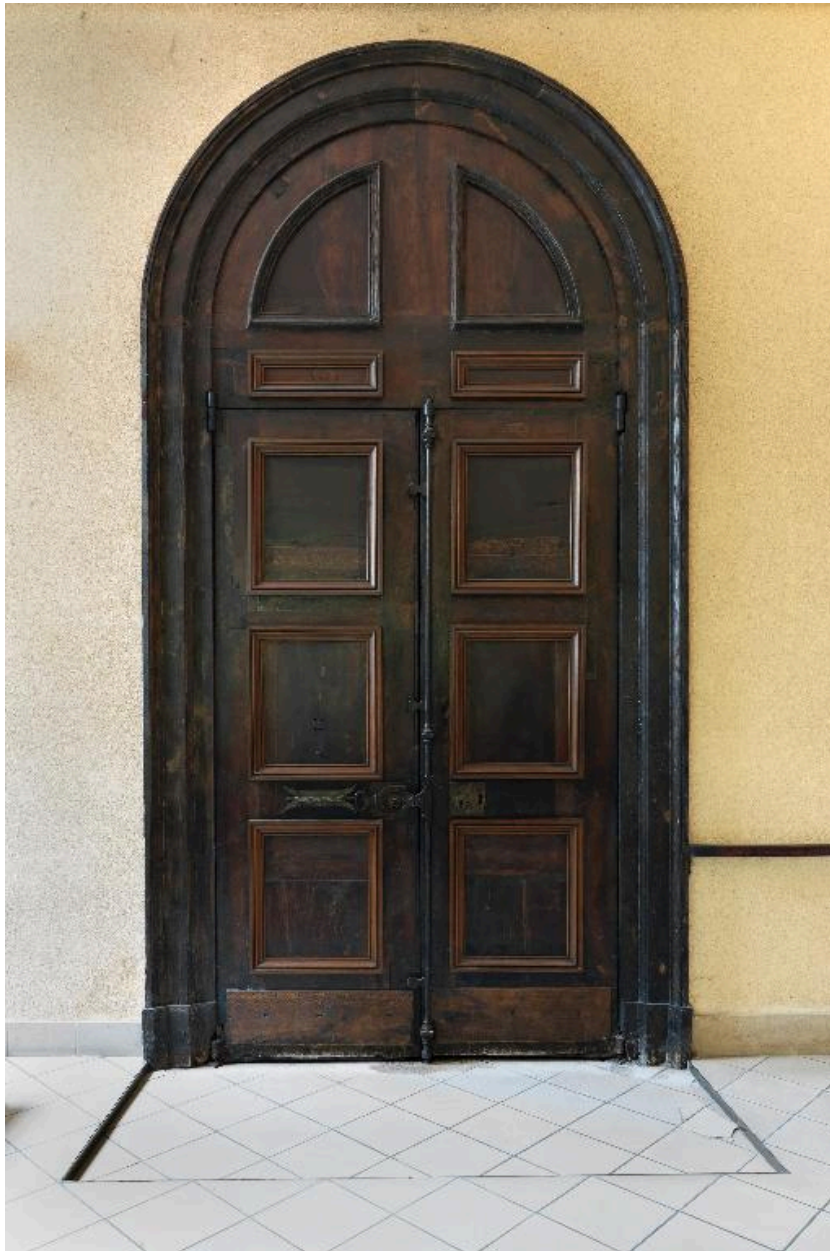
Ancienne porte du pensionnat, vue intérieure
