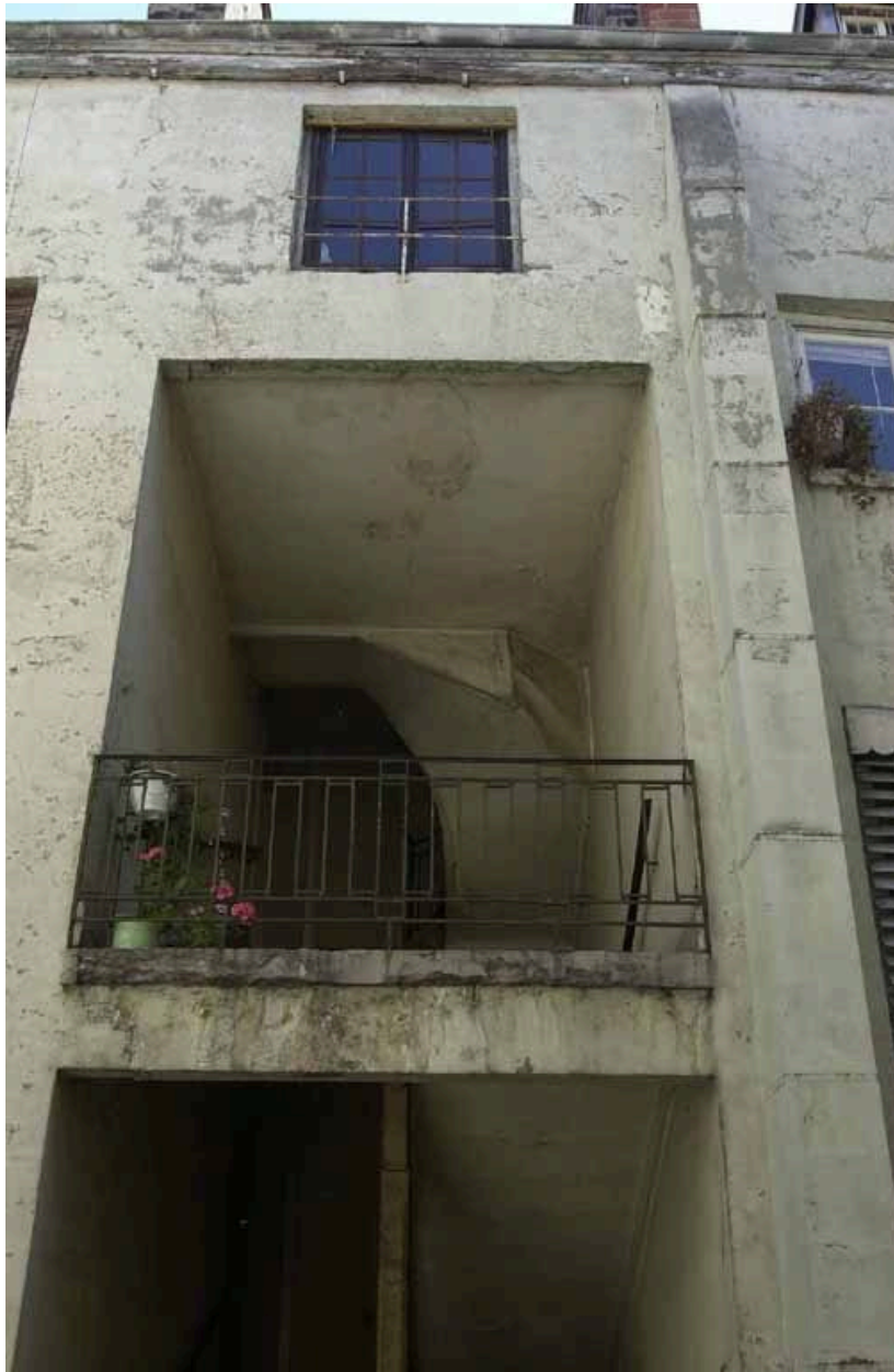
La cour : détail de la travée d'escalier
