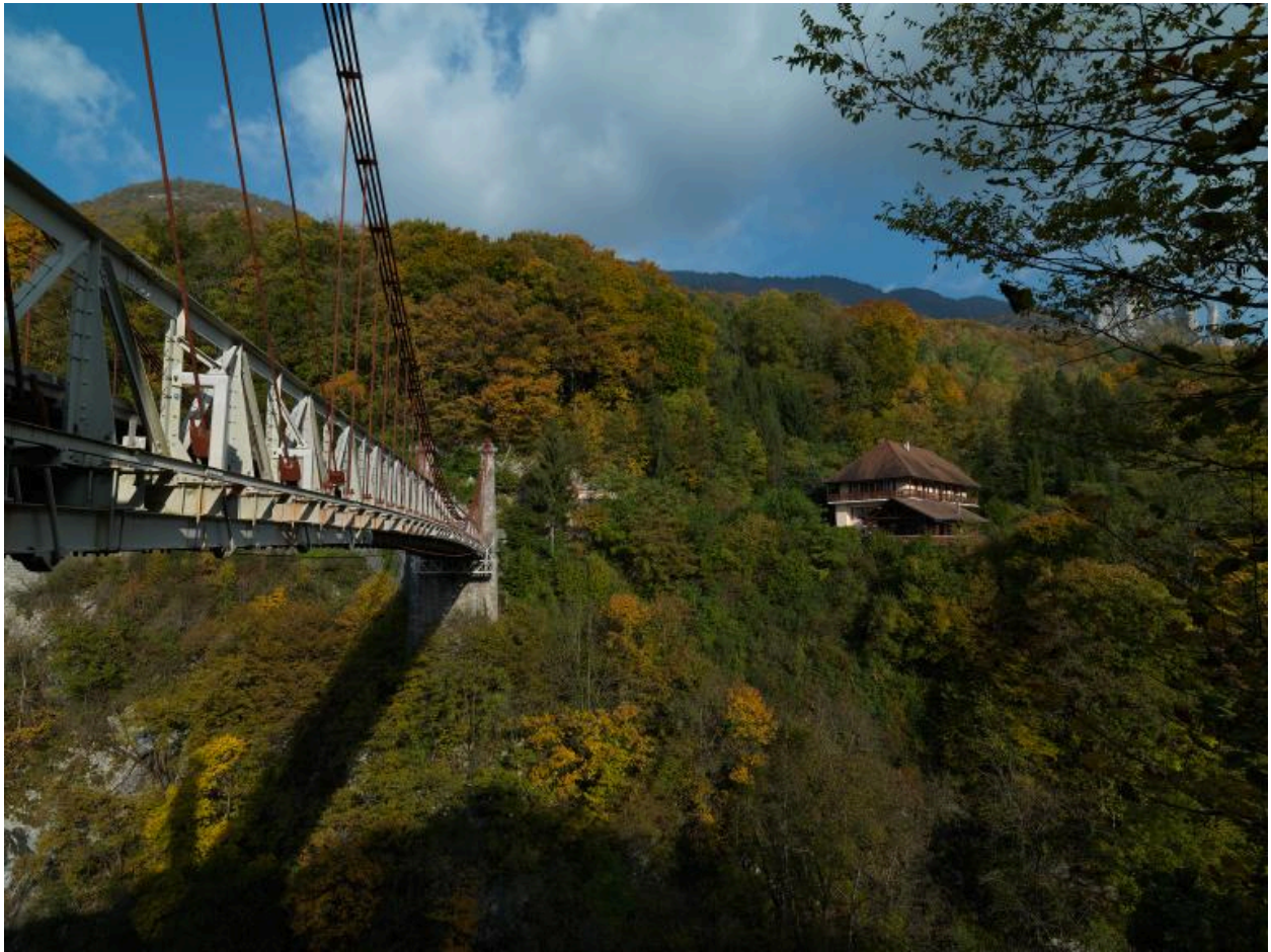
Vue en enfilade du pont avec, à droite, l'auberge de Gruffy.
