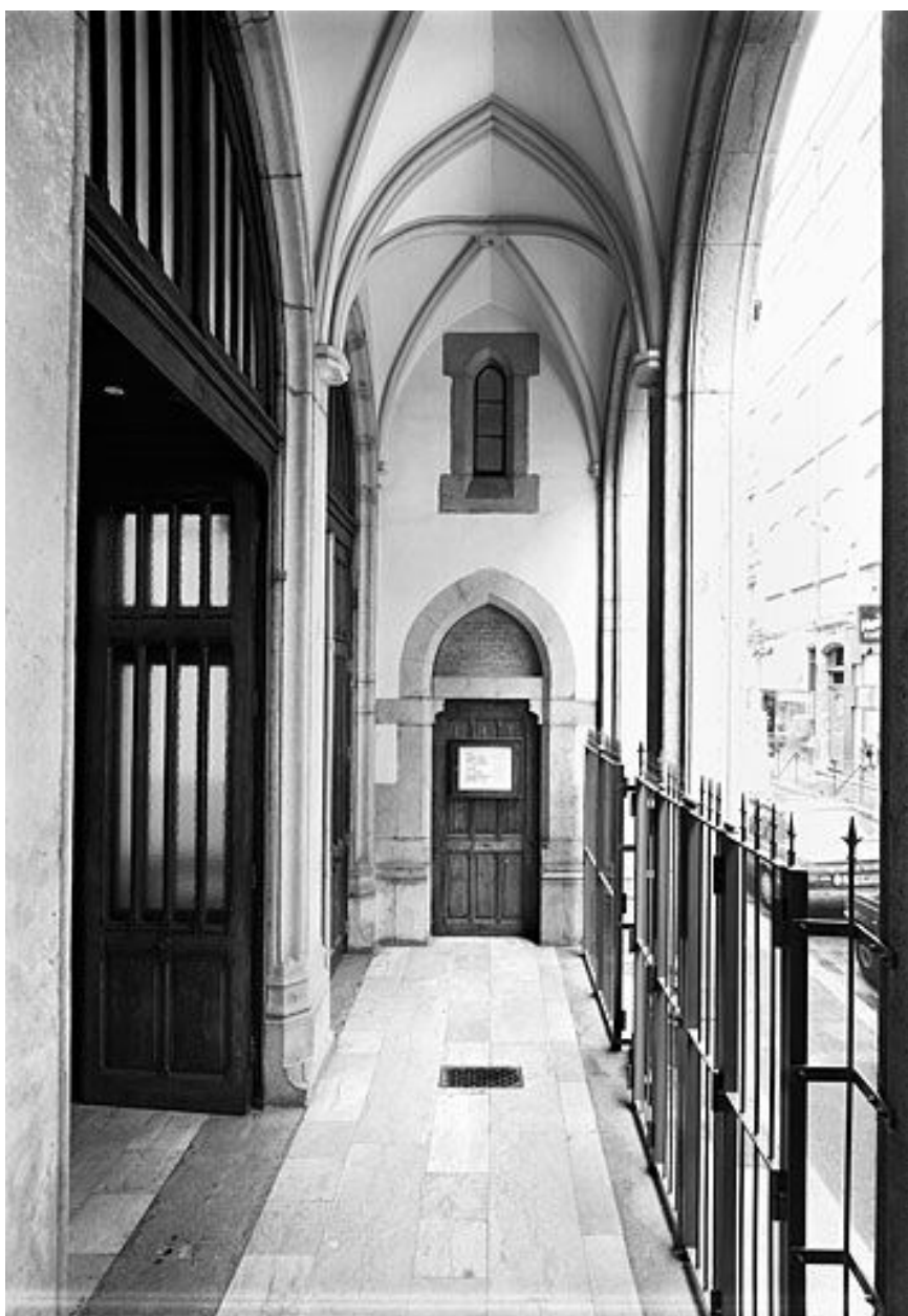
Bâtiment à étages, porche
