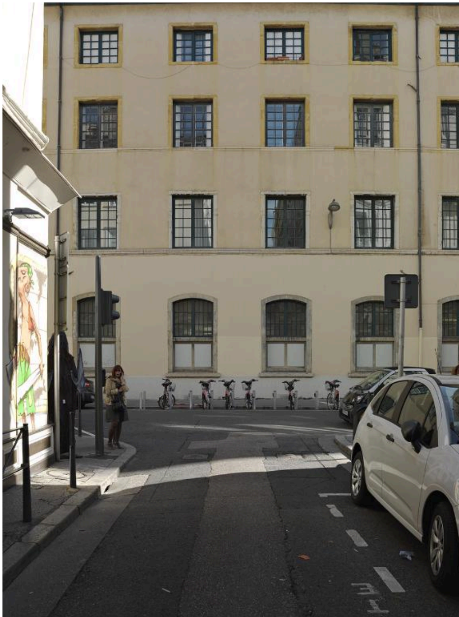
Elevation principale, vue partielle depuis la rue Mulet
