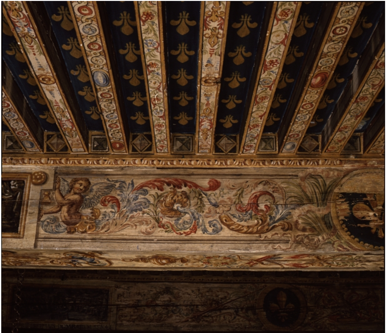
Poutre 2, face nord, support droit du cartouche.
