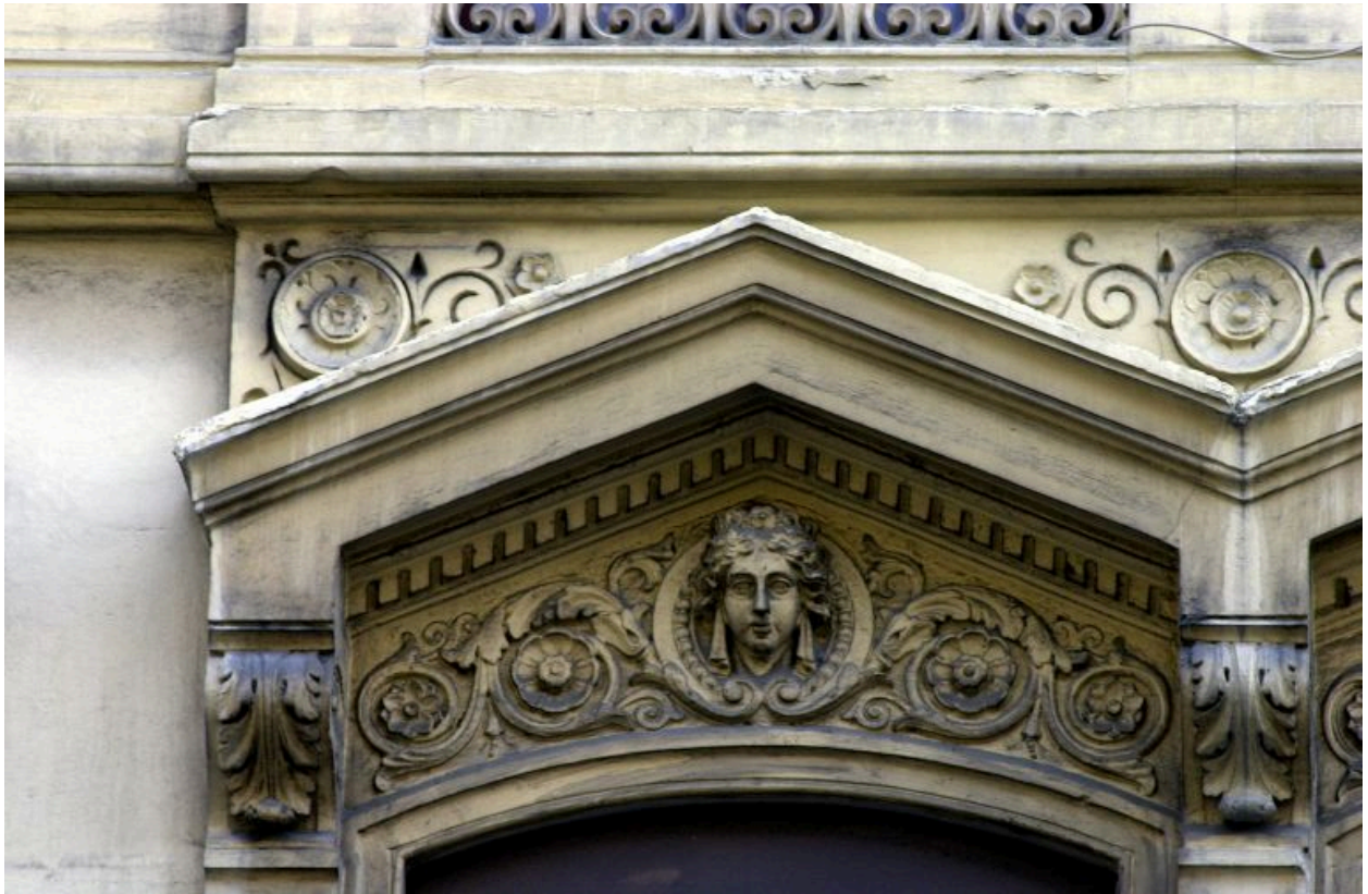
Façade principale, sommet des fenêtres du premier étage
