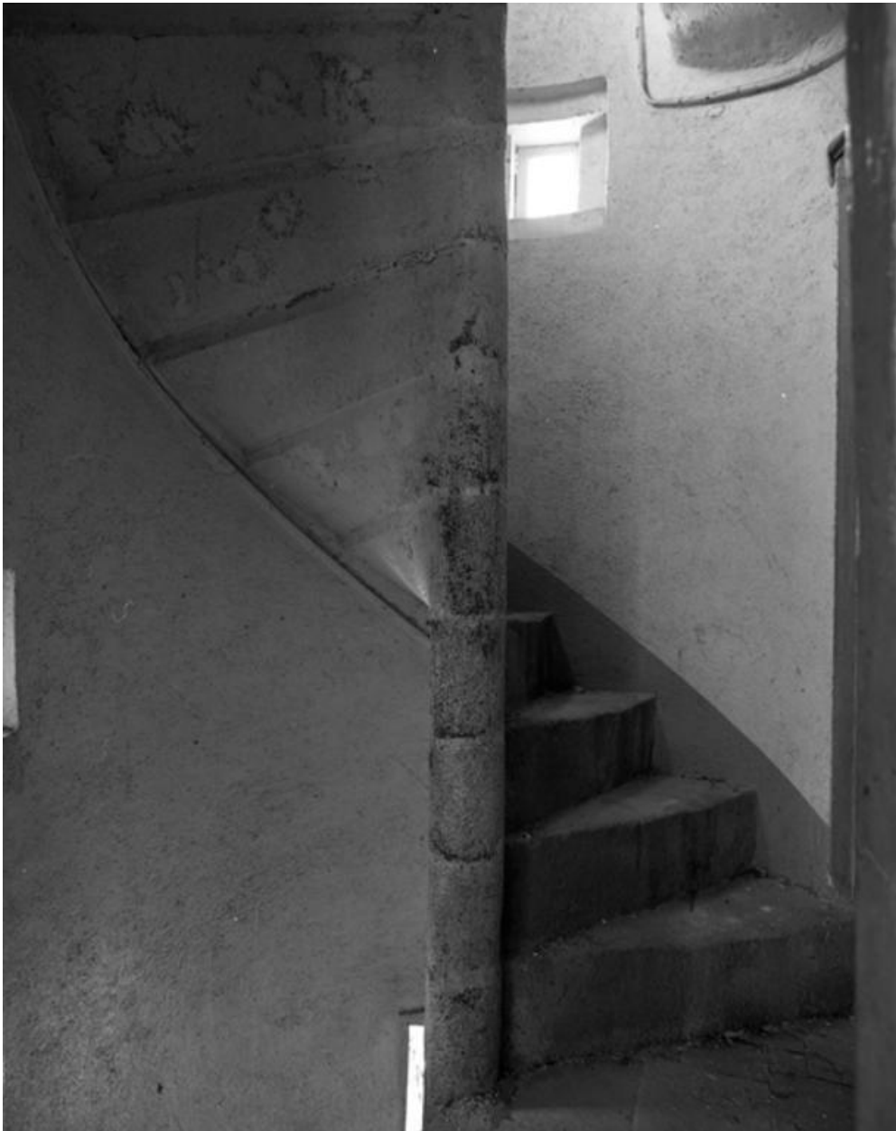
Détail de l'escalier en vis d'accès aux étages.
