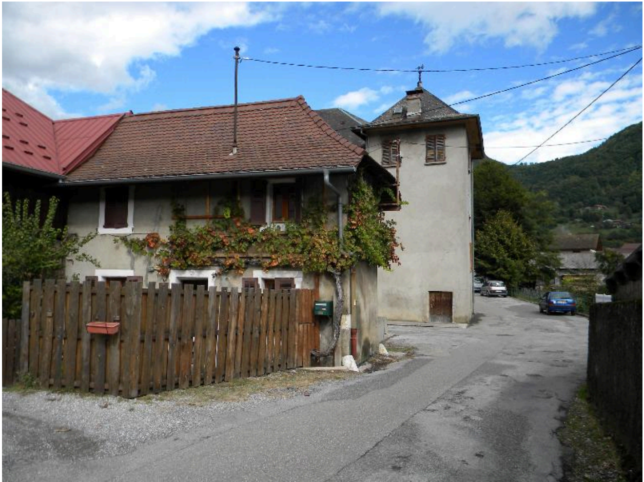
Vue d'une maison de village aux encadrements peints (2008 C3 402)
