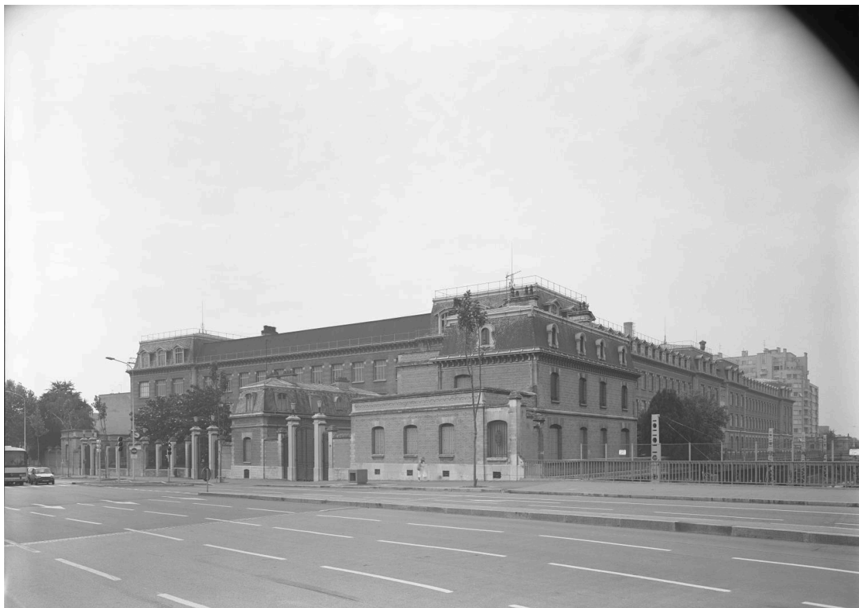
Façades ouest et sud des bâtiments d'exploitation. Bâtiment T (conciergerie sud), façades ouest et sud
