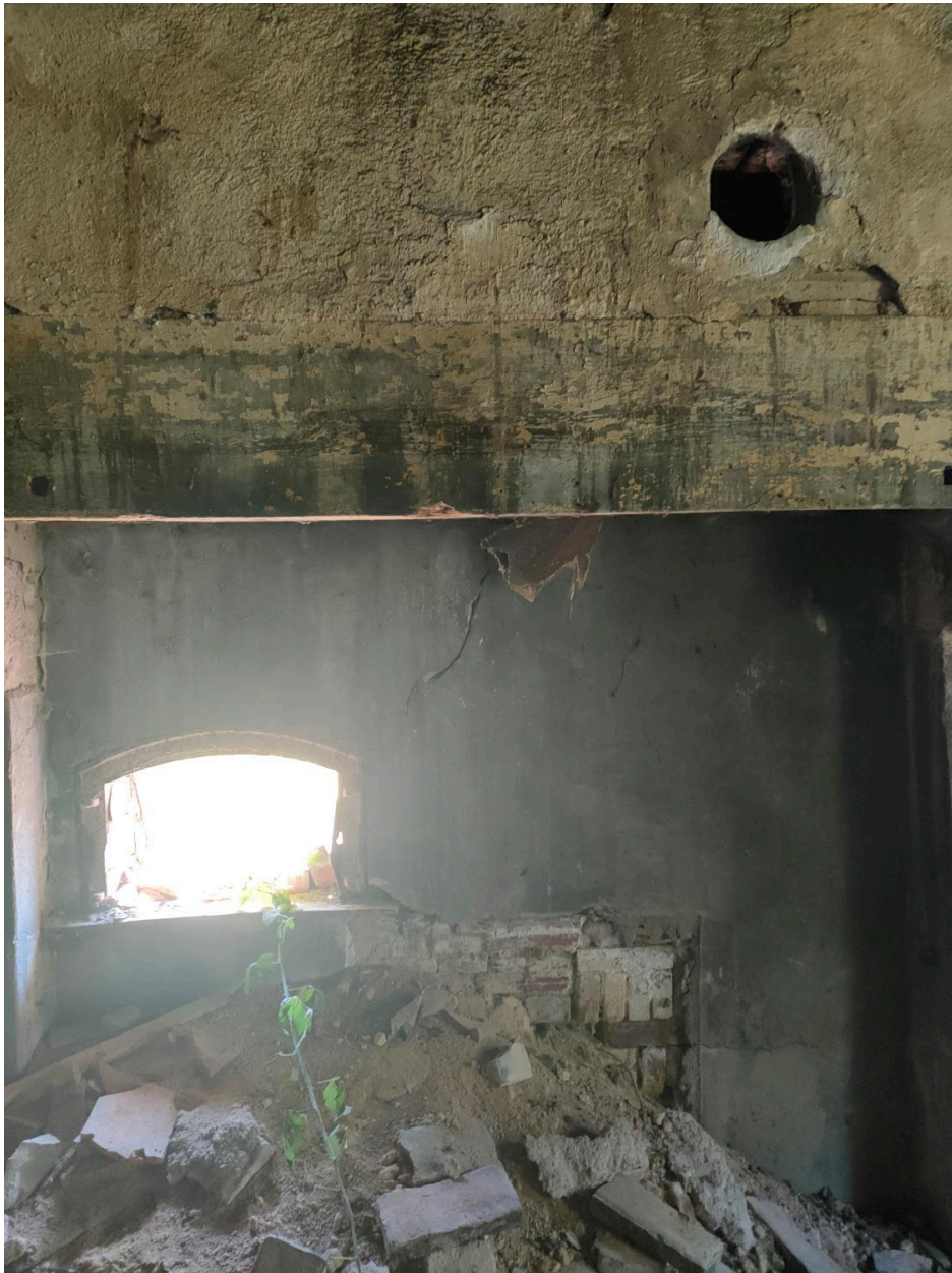
Vue de détail de la cheminée.
