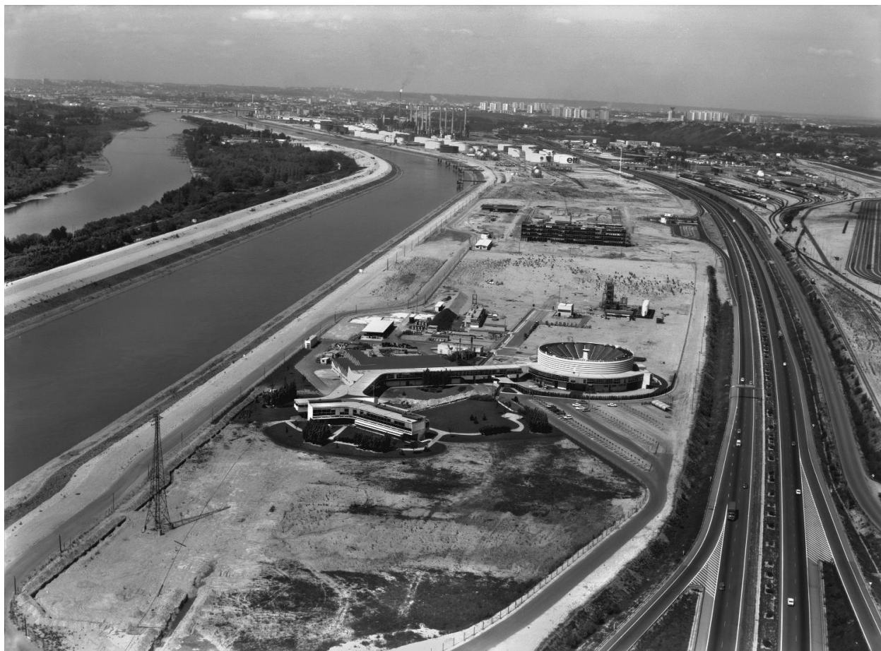
Vue aérienne du site IFPEN Lyon à Solaize (archives IFPEN)
