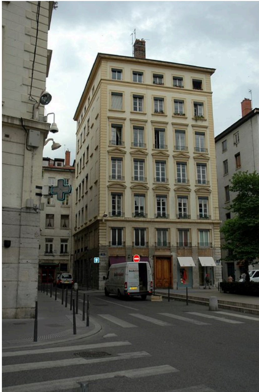
Lotissement concerté : 7 place des Célestins : façade principale de l'immeuble-îlot
