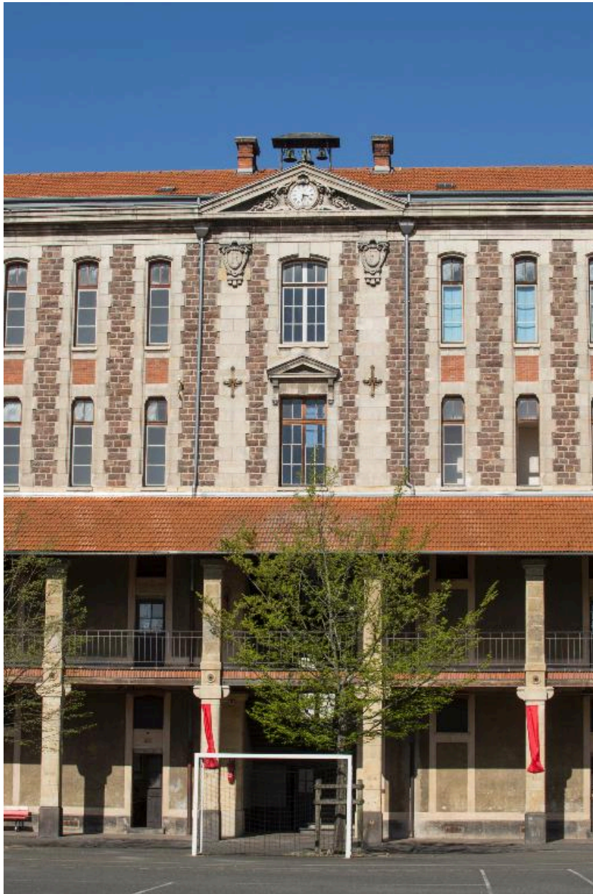
Bâtiment A. Travée centrale sur cour
