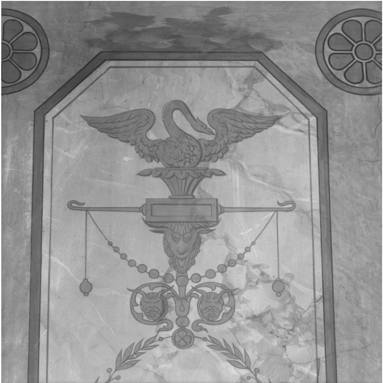
Détail d'un panneau des murs antérieur et de fond.
