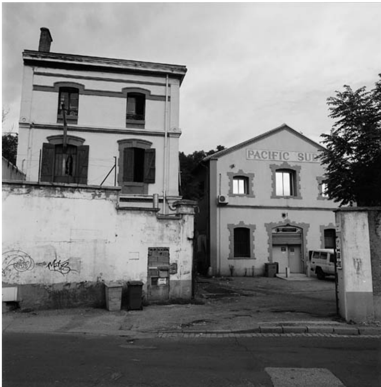
Vue d'ensemble est
