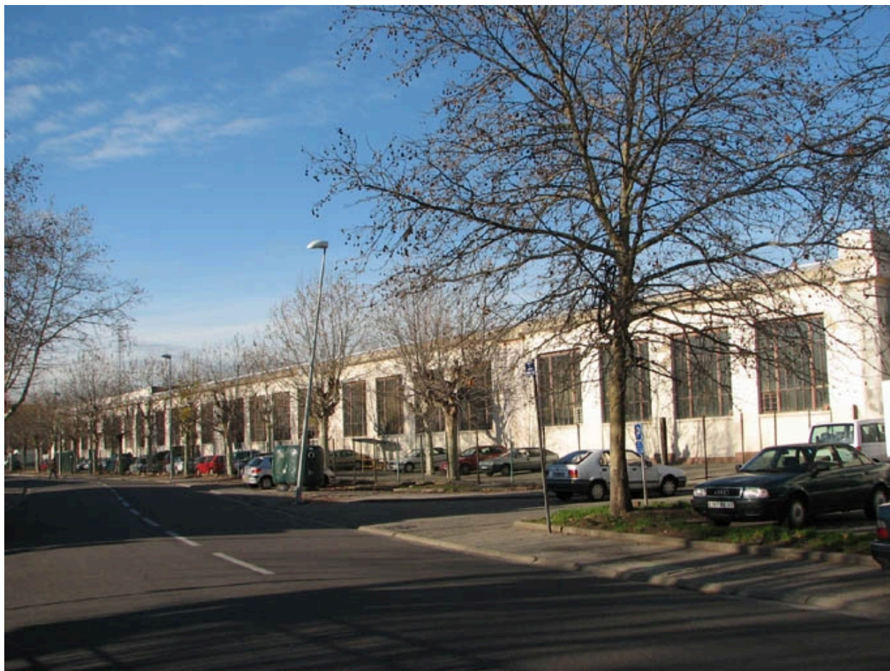
Vue ouest des ateliers shed
