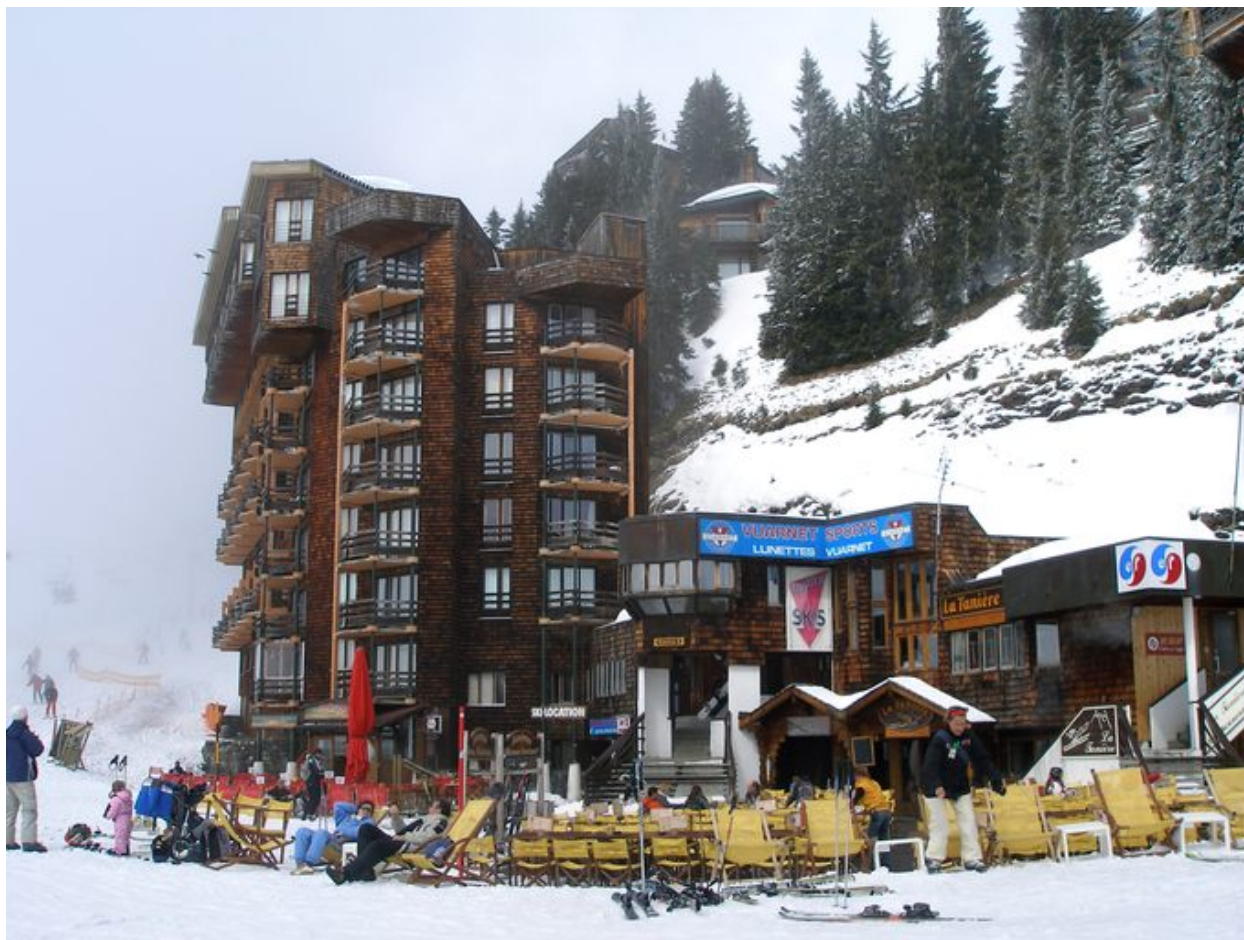
Vue du pignon aval, au sud
