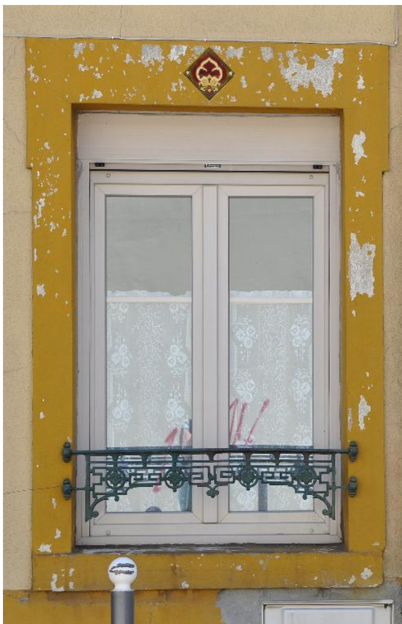
Vue rapprochée d'une fenêtre
