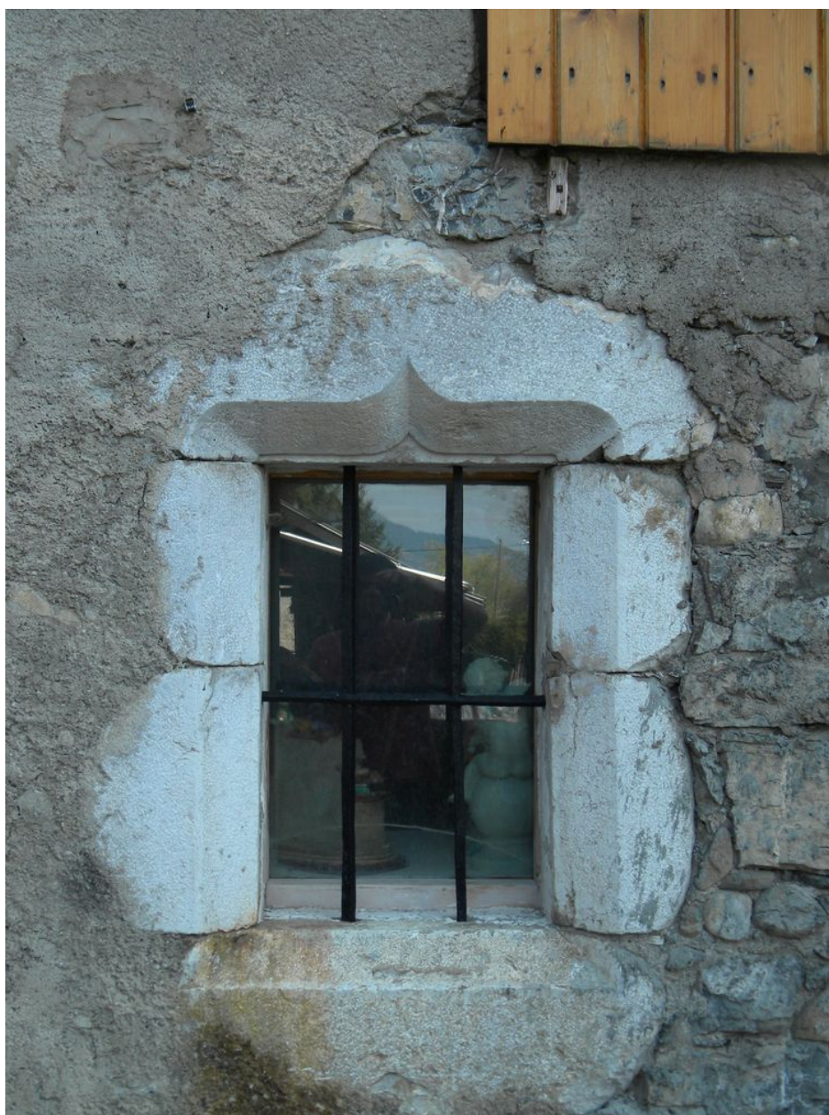
Fenêtre à accolade en façade nord de la ferme Charrier (2008 B8 1134).
