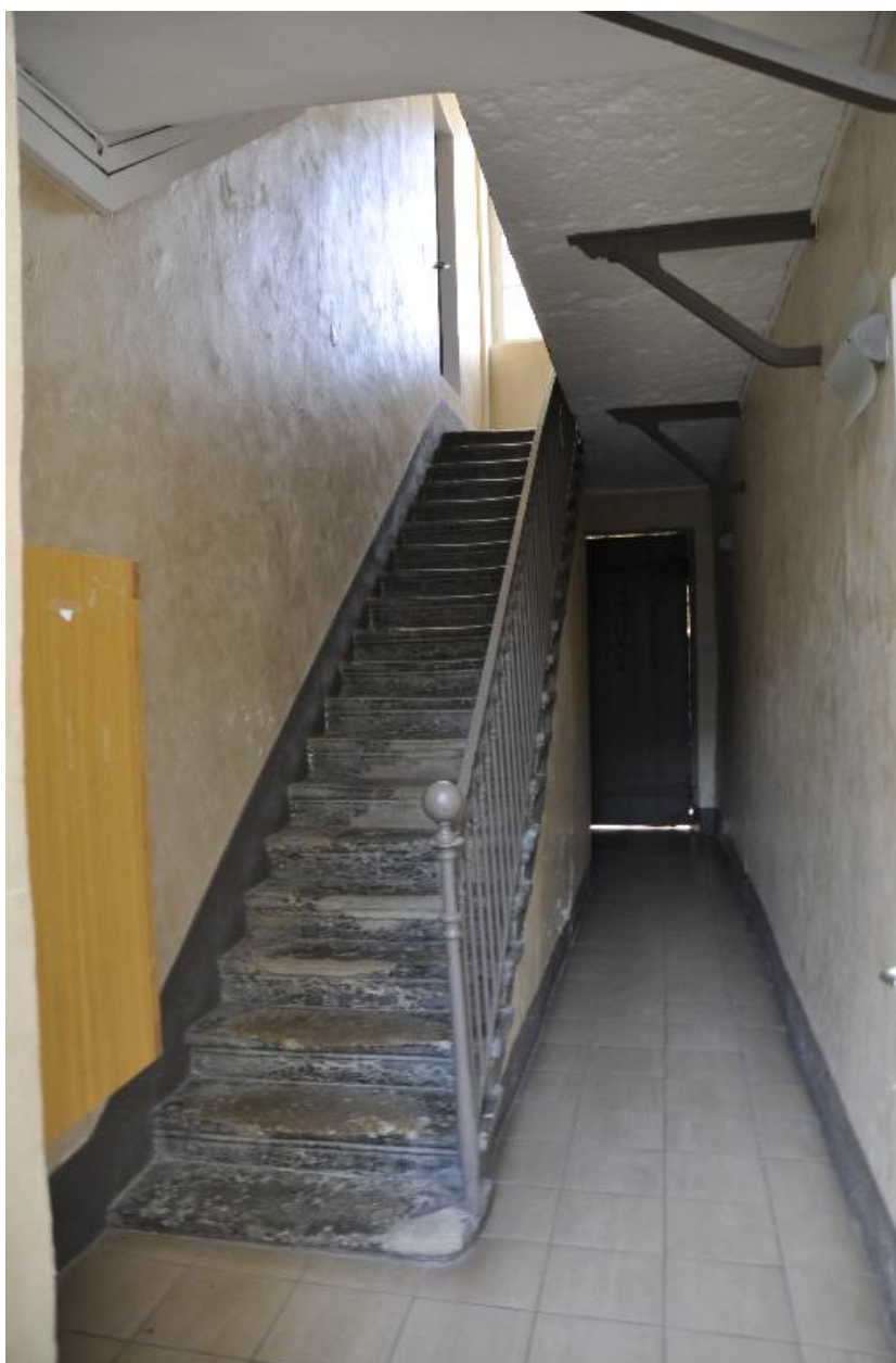
Vue du départ de départ de l'escalier
