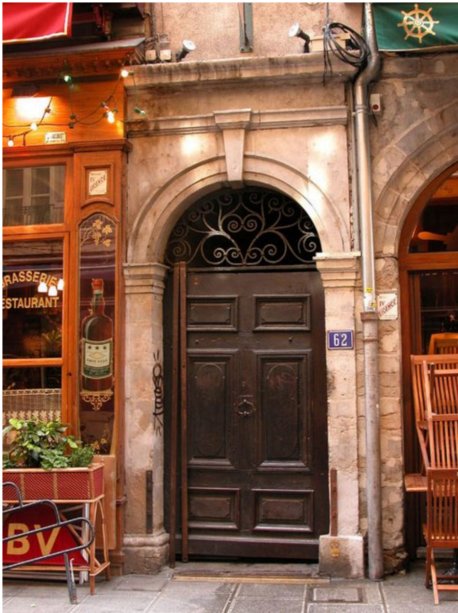
Détail de la porte
