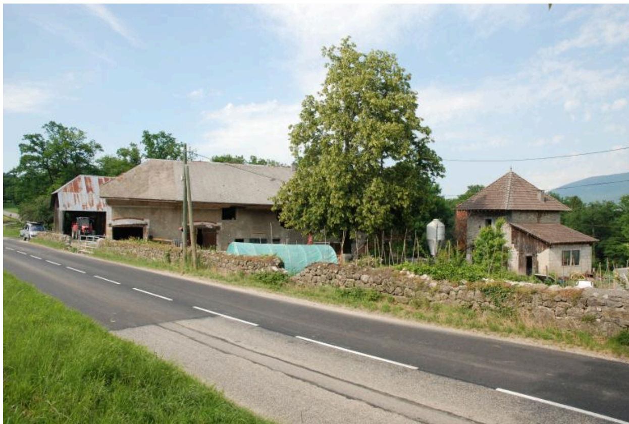
Vue générale depuis le sud-ouest.
