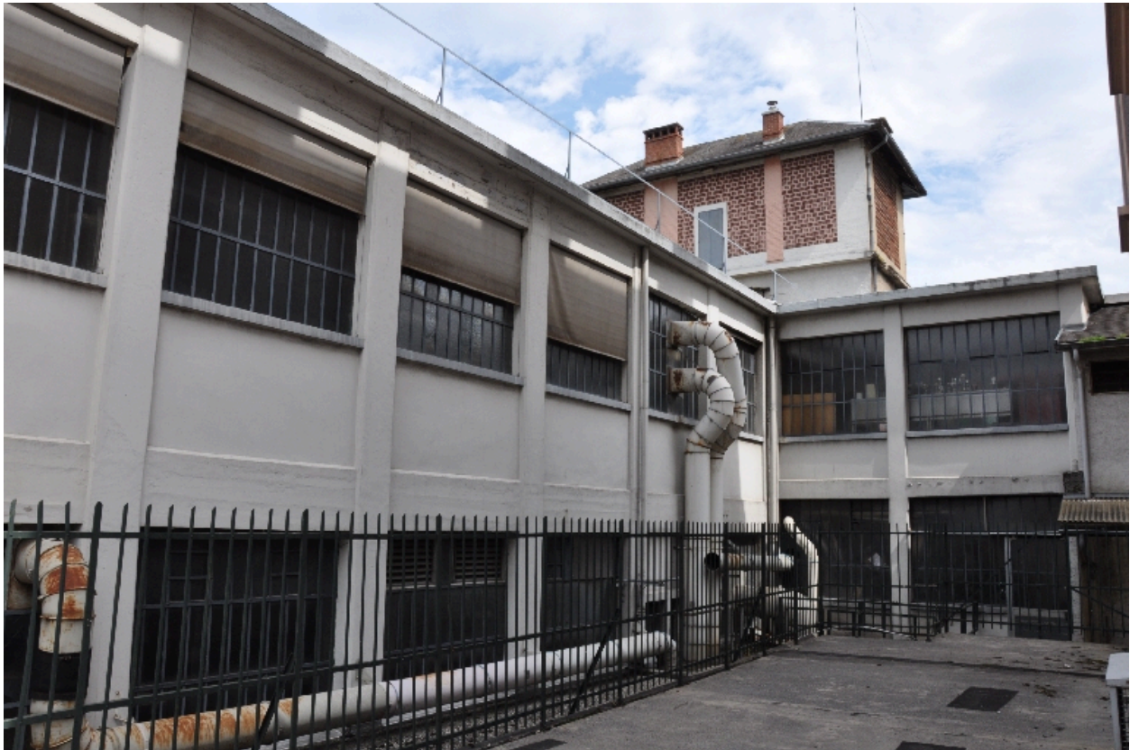
Vue arrière du bâtiment
