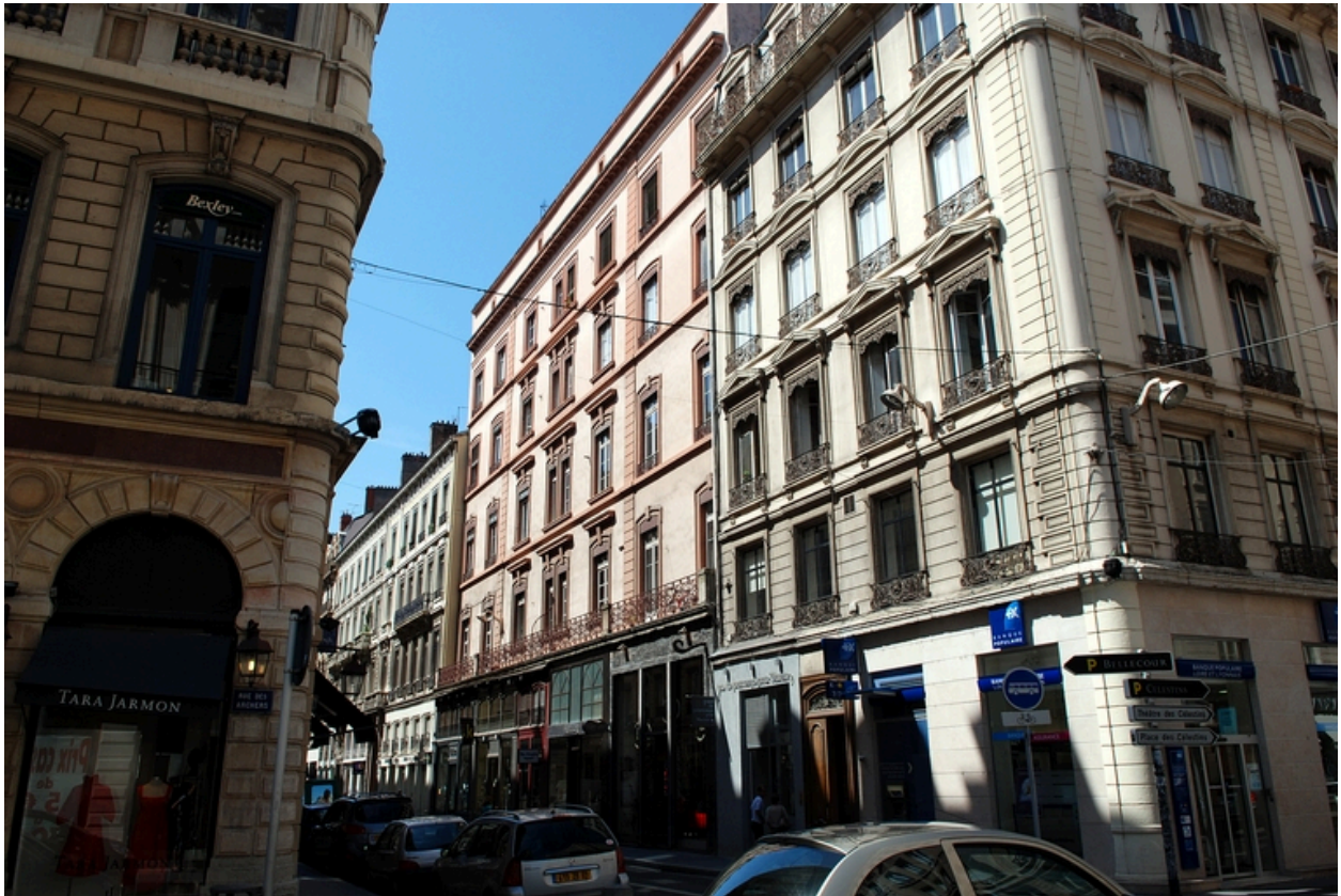
Vue de situation rue Gasparin
