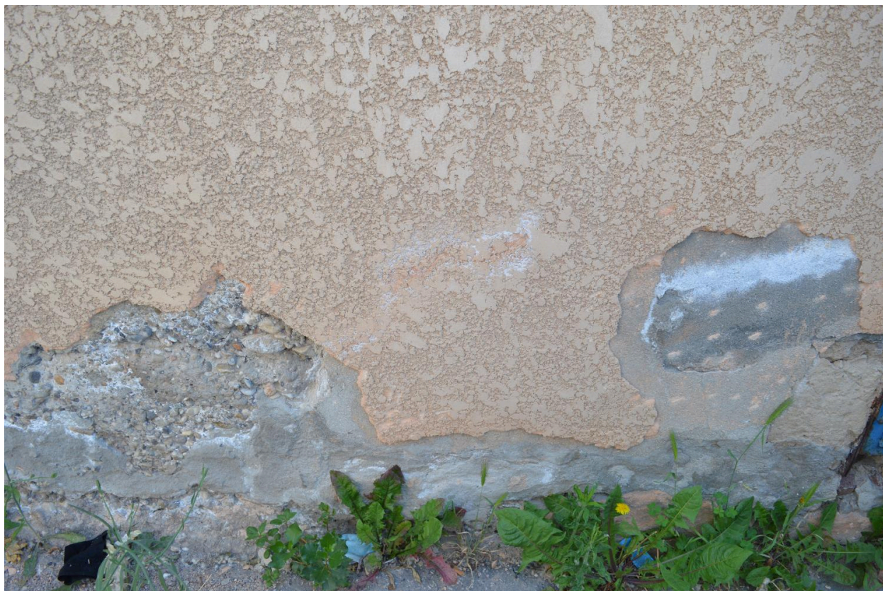
Usine Chimitechnic - matériaux des bâtiments et murs d'enceinte - rue Marx Dormoy
