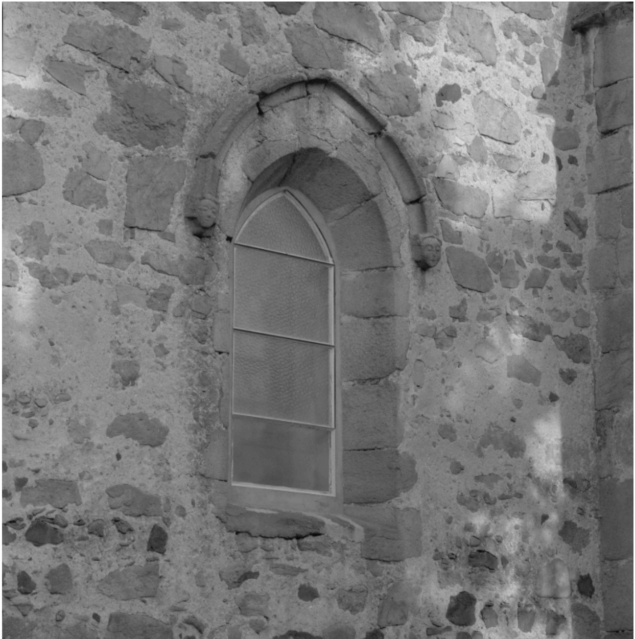
Vue d'ensemble d'une baie de l'élévation sud avec moulure décorative en arc brisé au-dessus.
