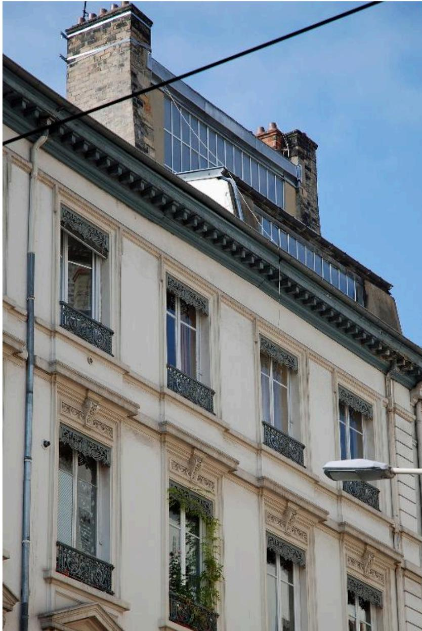
Élévation latérale : étage de comble partiellement aménagé avec verrière et toit-terrasse
