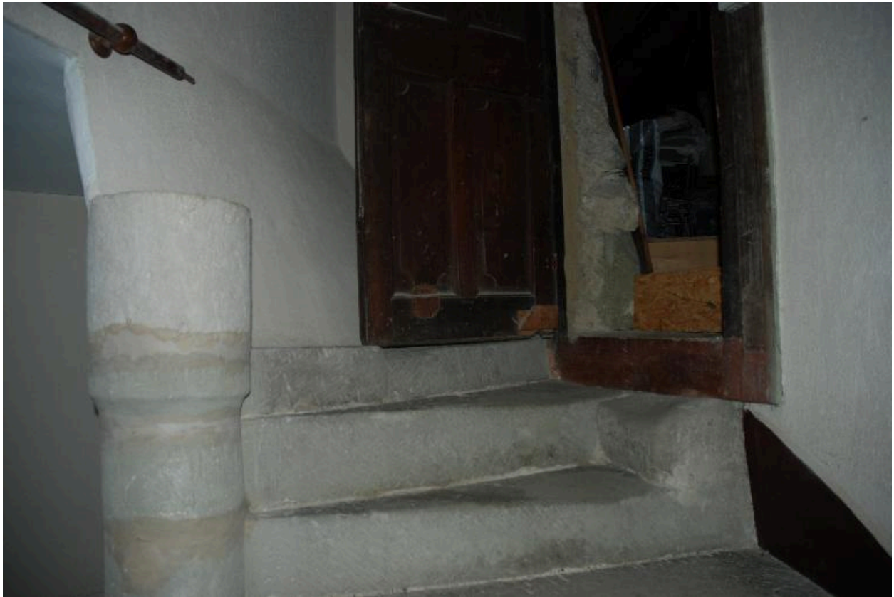
Escalier en vis. Base de la porte d'accès au comble à surcroît.
