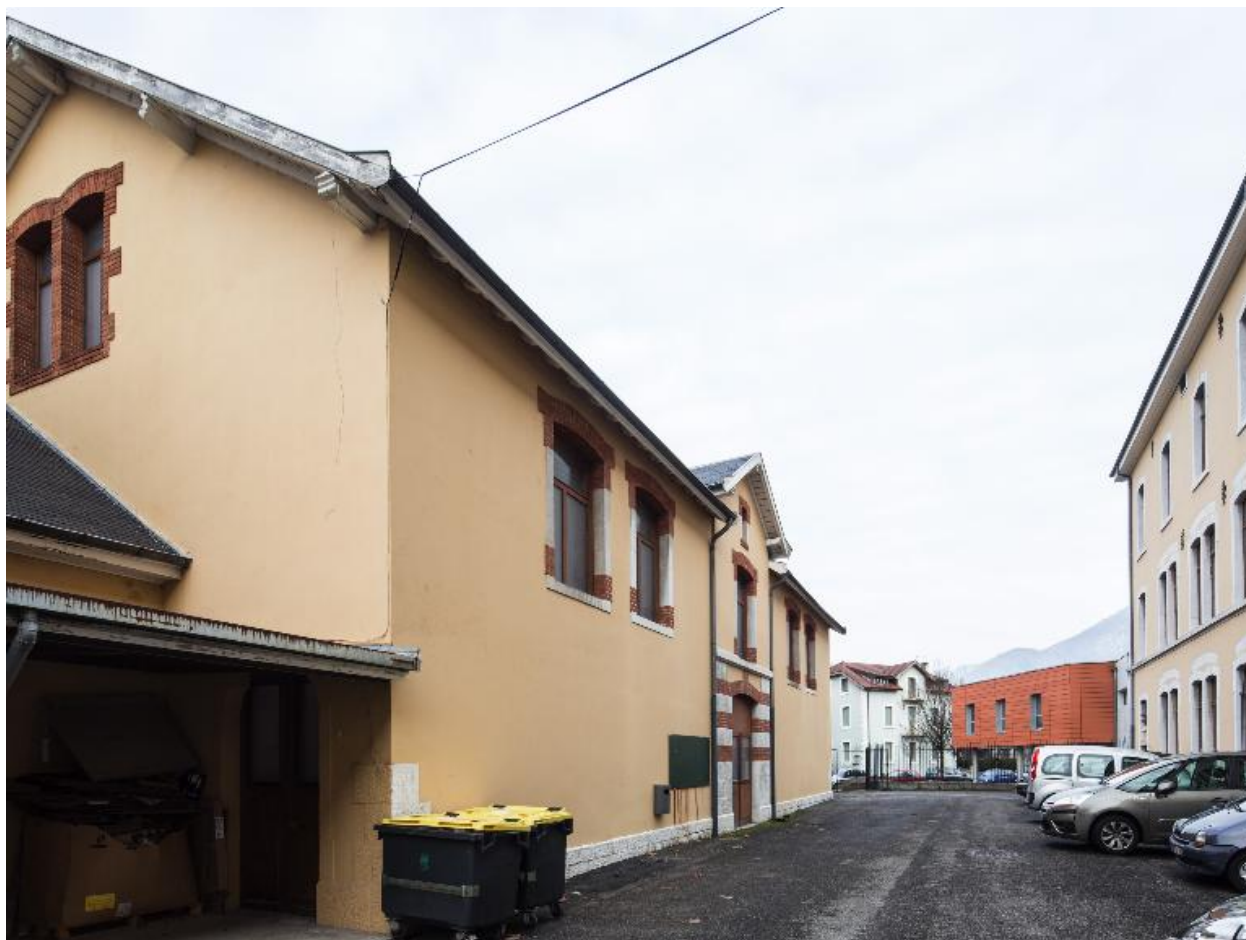
Cour nord : bâtiment de l'ancien gymnase à gauche, le nouveau gymnase au fond.
