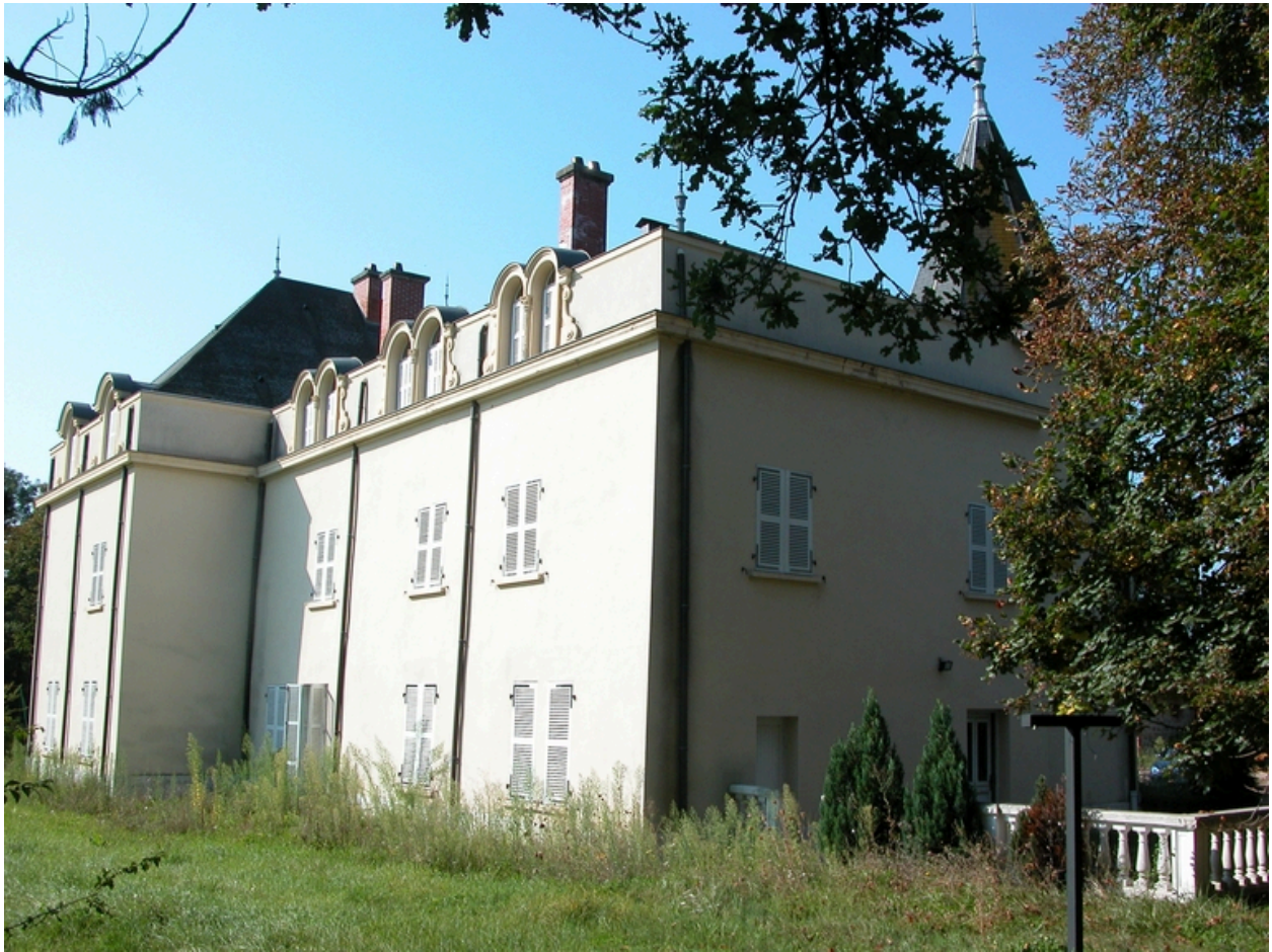
Vue d'ensemble de la demeure, depuis le nord-ouest.
